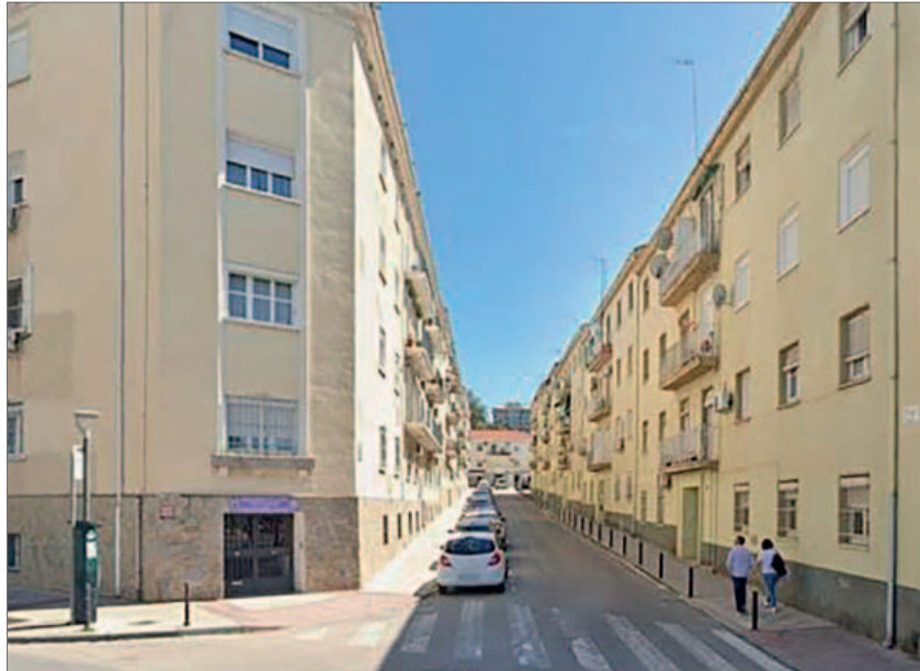
A VISTA DE BARRIO. Imagen de la zona donde se han realizado los trabajos de rehabilitación energética.
